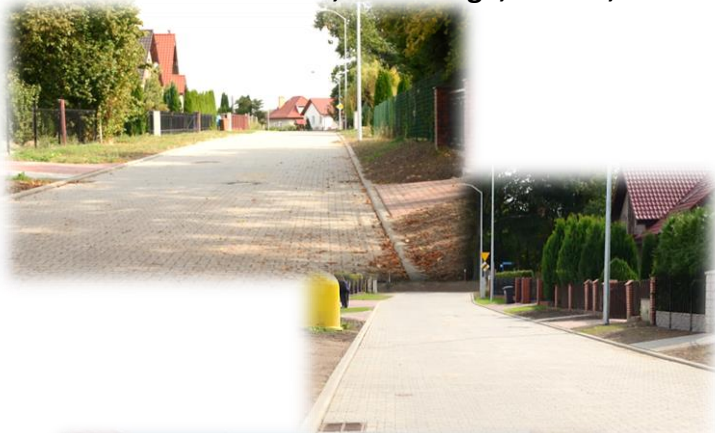
Przebudowa ulicy Mickiewicza
